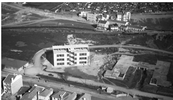
Fig.2.13. Vista aérea do Pavilhão C ou da Rádio do Instituto Português de Oncologia (1933) Carlos Ramos (1897-1969)
