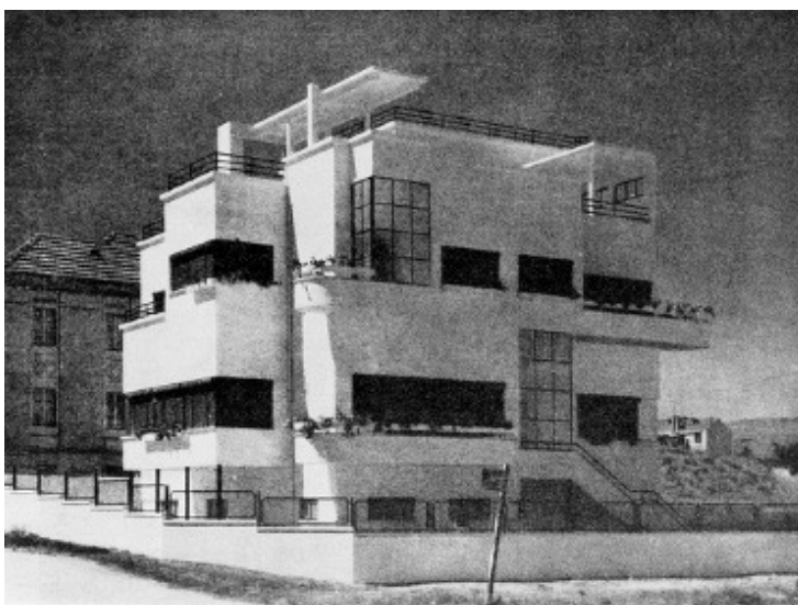
Fig.2.47 Moradia na Avenida Columbano Bordalo Pinheiro (1937) demolida – Cassiano Branco (1897-1970) ©Biblioteca de Arte da Fundação Calouste Gulbenkian – Estúdio Mário Novais
