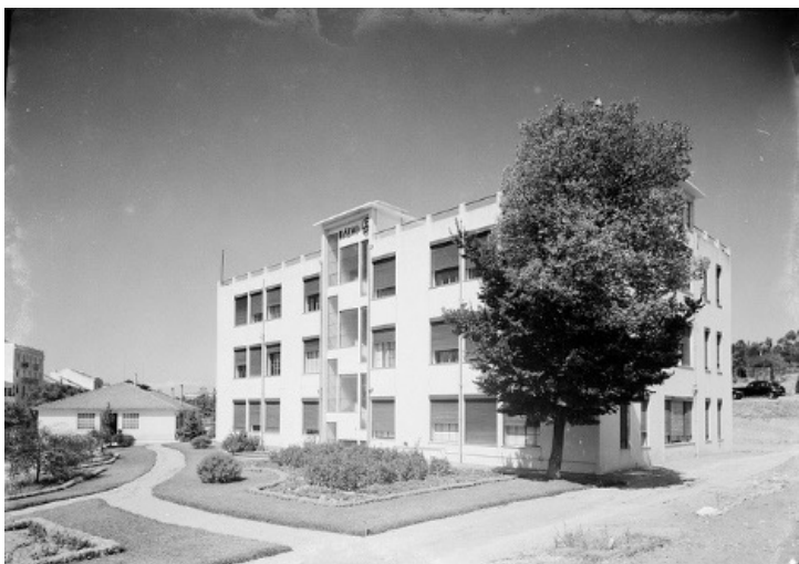
Fig.2.14. Pavilhão C ou da Rádio do Instituto Português de Oncologia (1933) Carlos Ramos (1897-1969)
