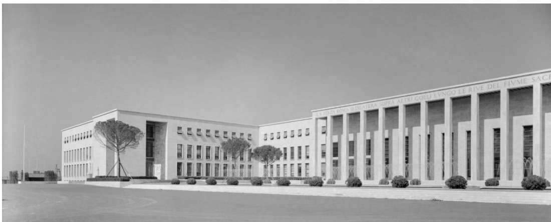
Fig.1.19 Palazzo Uffici (1940) – Marcello Piacentini (1881-1960)
