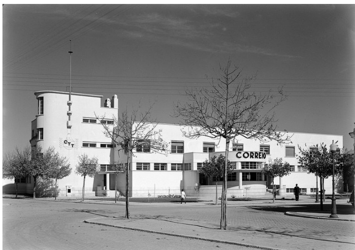
Fig.1.69 Edifício dos CTT, Setúbal (1937-41) - Adelino Nunes (1903-1948)
