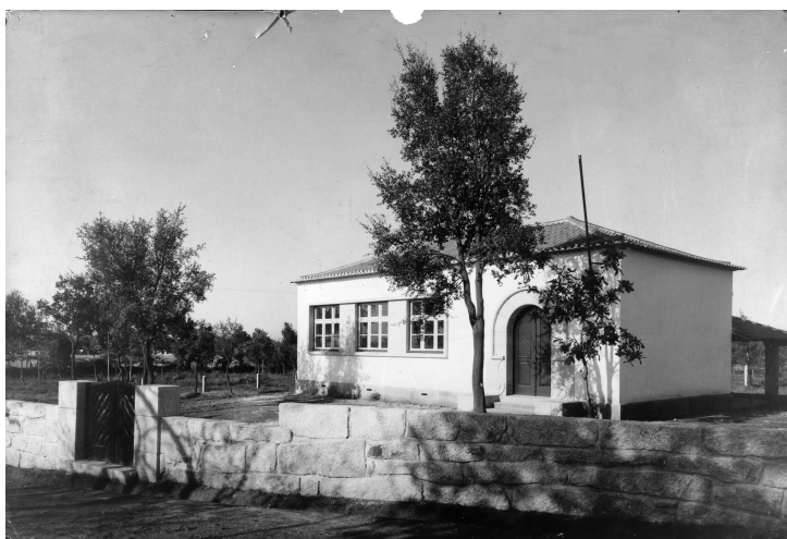
Fig.1.6 Escola Primária da Maia – escola do Plano dos Centenários – Rogério de Azevedo (s.d)
