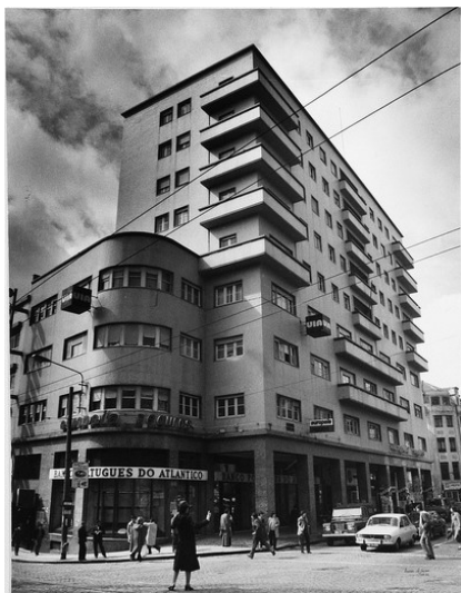
Fig. 1.64 Edifício Rialto, Porto (1941) - Rogério de Azevedo (1898-1983) ©Biblioteca de Arte da Fundação Calouste Gulbenkian - Estúdio Mário Novais (1933-1983)
