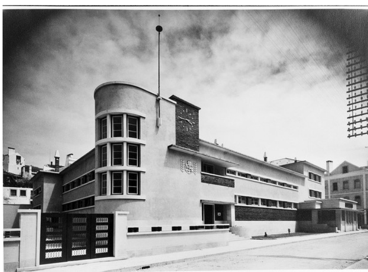
Fig.1.70 Edifício dos CTT, Figueira da Foz (1937-41) - Adelino Nunes (1903-1948)
