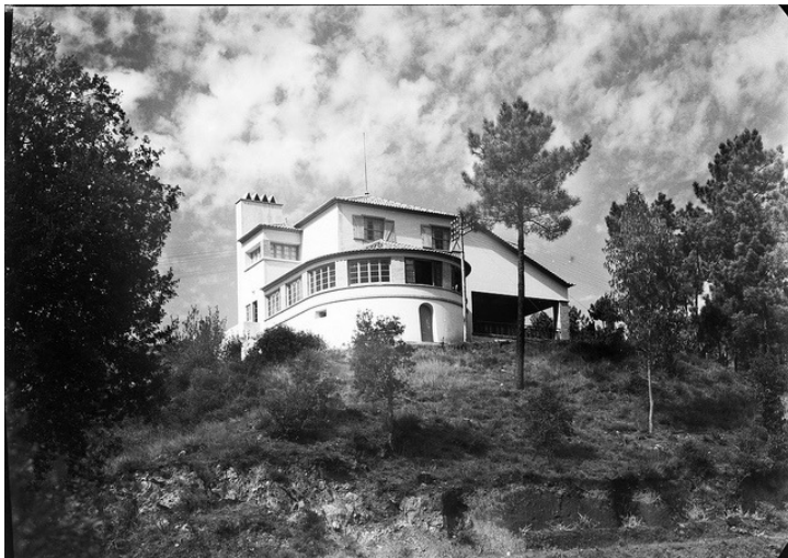
Fig.1.62 Pousada Regional de Serém do Vouga (1942-1948) - Rogério de Azevedo (1898-1983) ©Biblioteca de Arte da Fundação Calouste Gulbenkian - Estúdio Mário Novais (1933-1983)
