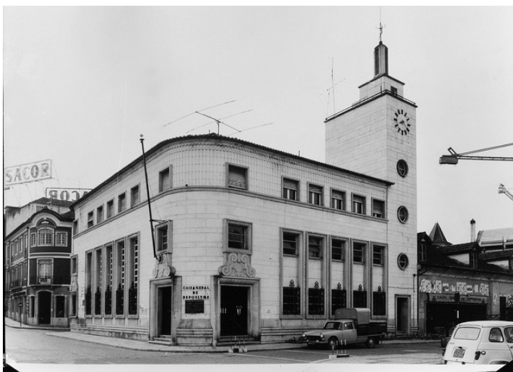
Fig.1.31 Caixa Geral de Depósitos, Leiria (1938-1943) – Cristino da Silva (1896-1976) ©Fundação Calouste Gulbenkian - Estúdio Mário Novais (1933-1983), 1982
