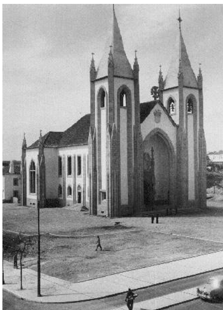
Fig. 1.28 Igreja do Santo Condestável (1946-1951) – Vasco Regaleira (1897-1968) © Arquivo Municipal de Lisboa
