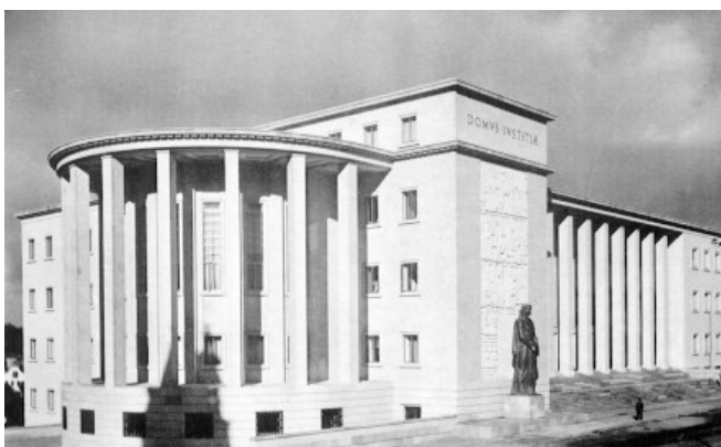
Fig. 2. Palácio da Justiça, Porto (1961) - Raul Rodrigues Lima (1909-1979) © Tribunal da Relação do Porto
