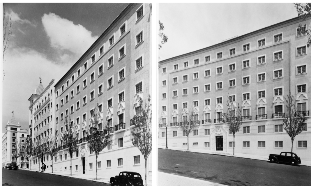
Fig.1.26 e fig.1.27 Edifício de habitação Av. Sidónio Pais, nº12 (1942) – Cristino da Silva (1896-1976)
