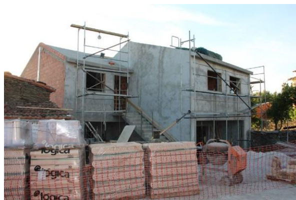
Figura 79: Construção recente, Vale de Juncal. (2016)
