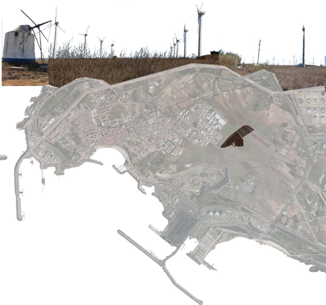
Parque eólico, com 12 turbinas.
