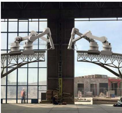
Fig.3 - Braços robóticos a “imprimir” ponte, rederização, MX3D Bridge, 2017. (mx3d.com, 2017, 8)
