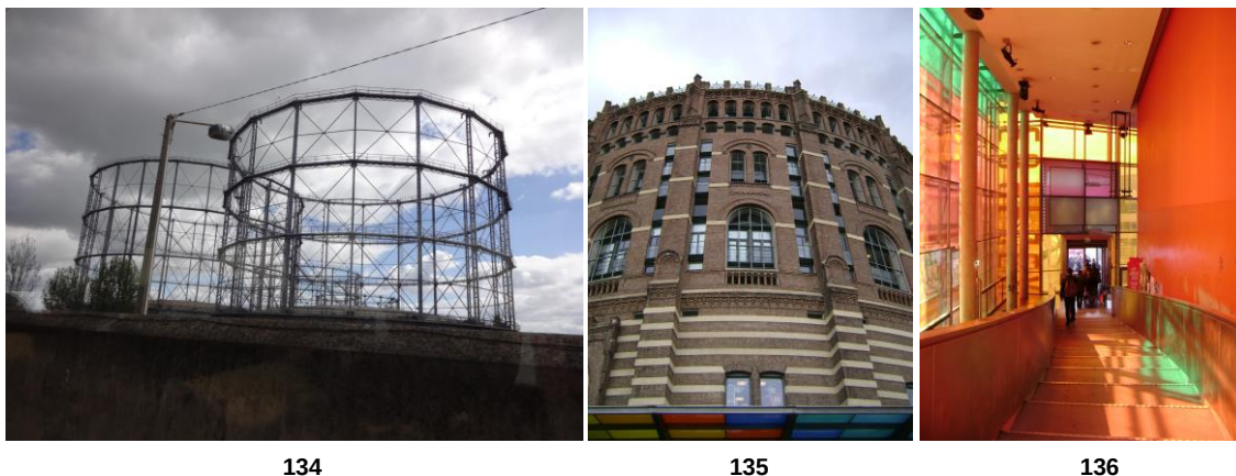
Figura 134. Vista dos antigos Gasómetros da Fábrica de Gás da Matinha, Matinha, Lisboa. (Fotografia da Autora; abril 2015).
