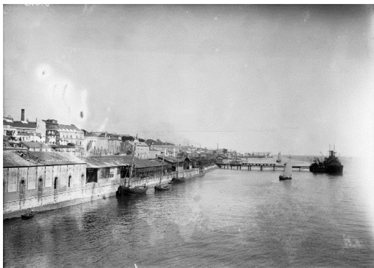
Figura 5. Vista de Santa Apolónia antes da realização das obras do muro do cais.
