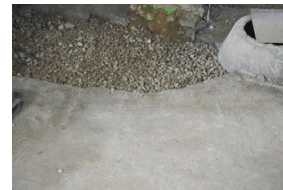
09. Execução da camada de betonilha de regularização.
