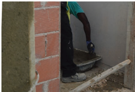
07. Aplicação da alvenaria de tijolo.
