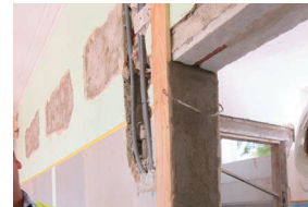
09. Preenchimento dos restantes espaços com argamassa de selagem.
