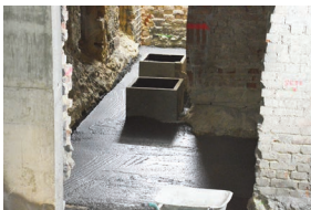
10. Aplicação da emulsão betuminosa para impermeabilização.
