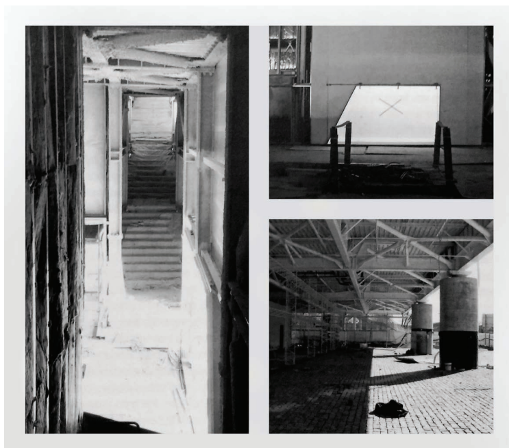
Figura 28. Fotografias diversas da fase de acabamento da construção.
