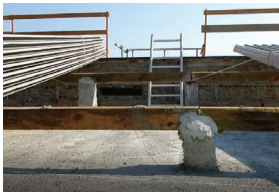
07. Estrutura complementar de apoio para suportar dos paineis sandwich.
