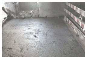
11. Betonagem da laje.
