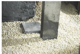
08. Camada drenante de brita compactada e nivelada.
