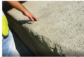
08. Camada de betão leve com partículas EPS já projetado.
