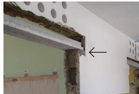
08. Argamassa nos remates do tipo Sika Grout e aplicação dos dois linteis de vigota auto-resistente de betão pré-esforçado de secção em "I".
