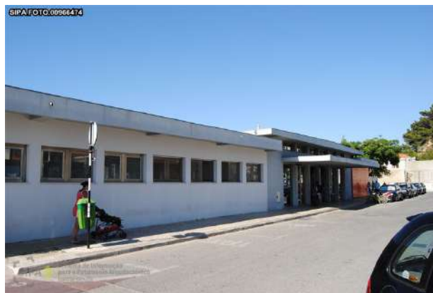
Figura 135. Estação Fluvial da Trafaria – 2011, Fotografia: Teresa Ferreira
