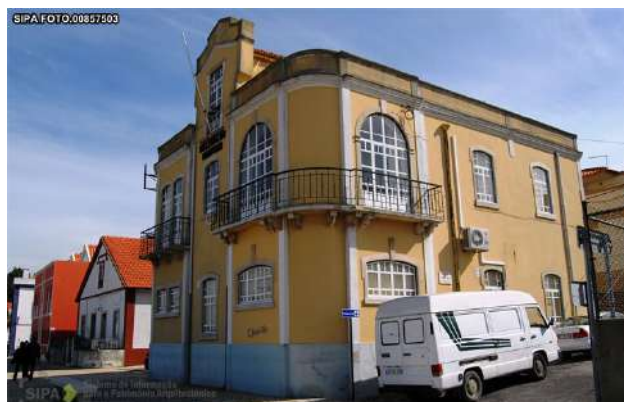
Figura 85. Edifício da Delegação Marítima da Trafaria – 2009, Fotografia: Desconhecido
