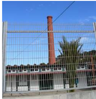
Figura 24. Antiga chaminé da Fábrica de Dynamite (3), sendo hoje a Escola B2+3 da Trafaria - 2019, Fotografia: Raquel Viveiros
