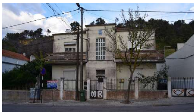
Figura 112. Casa na Avenida Bulhão Pato, nº45 – 2019, Fotografia: Raquel Viveiros
