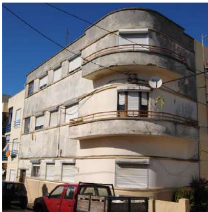
Figura 97. Edifício na Rua António José Martins – 2011, Fotografia: Teresa Ferreira
