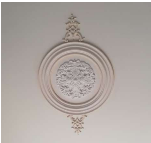
Figura 176. Pormenor teto em estuques depois da reabilitação – 2018/19, Fotografia: Arquiteto Nuno Galo Santos
