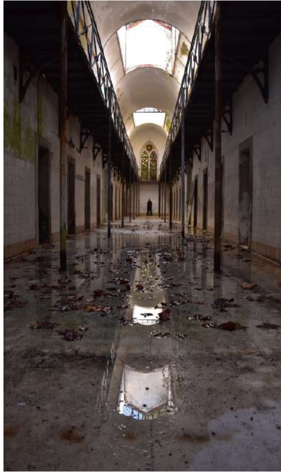
Figura 154. Lazareto / Presídio – interior: corredor – 2019, Fotografia: Milena de Villiers
