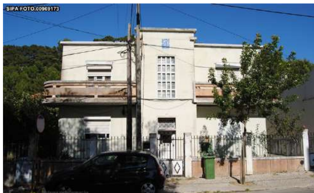
Figura 111. Casa na Avenida Bulhão Pato, nº45 – 2011, Fotografia: Teresa Ferreira
