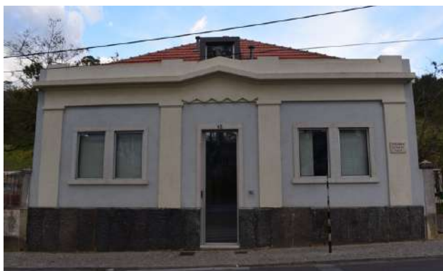
Figura 110. Casa na Avenida Bulhão Pato, nº65 – 2019, Fotografia: Raquel Viveiros
