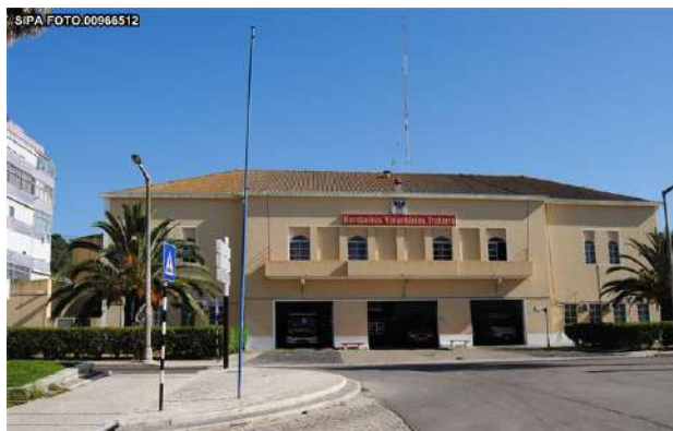
Figura 87. Quartel dos Bombeiros Voluntários da Trafaria – 2011, Fotografia: Teresa Ferreira
