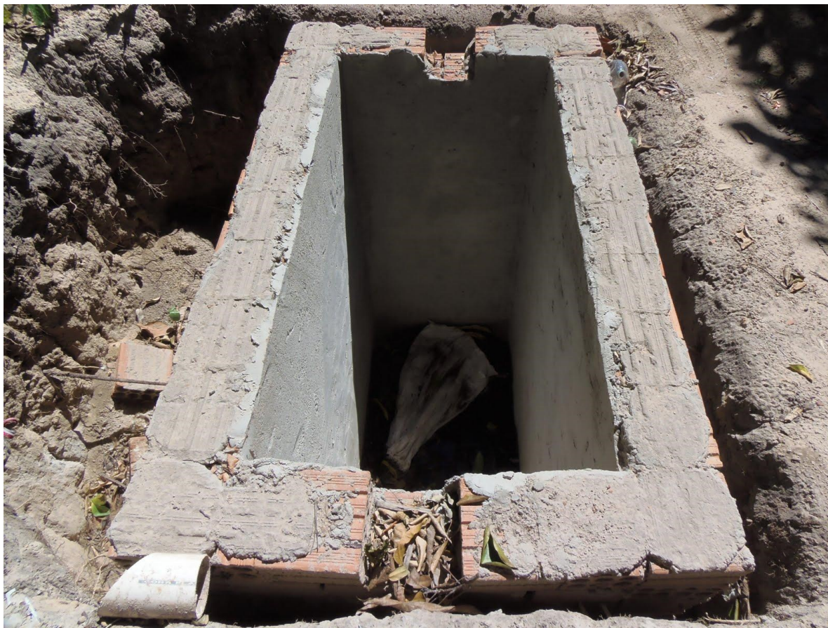
FOTO 30 – Fossa séptica de programa para saneamento básico inacabada. 2014
