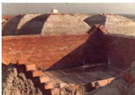
Abóbada em construção (interior), [1962]
