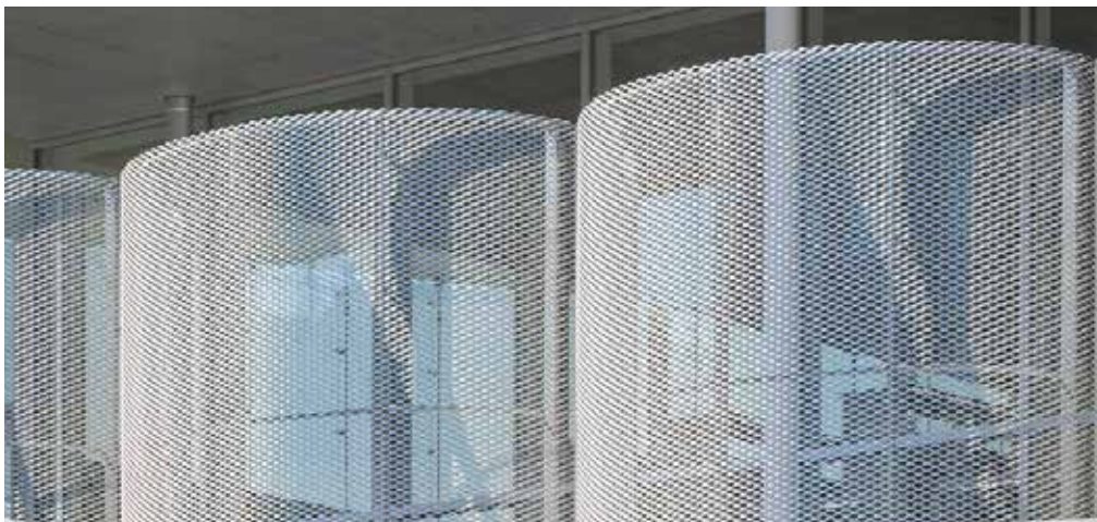
Figura 387 - Pormenor das chapas metálicas na fachada norte. © Vincent Hecht
