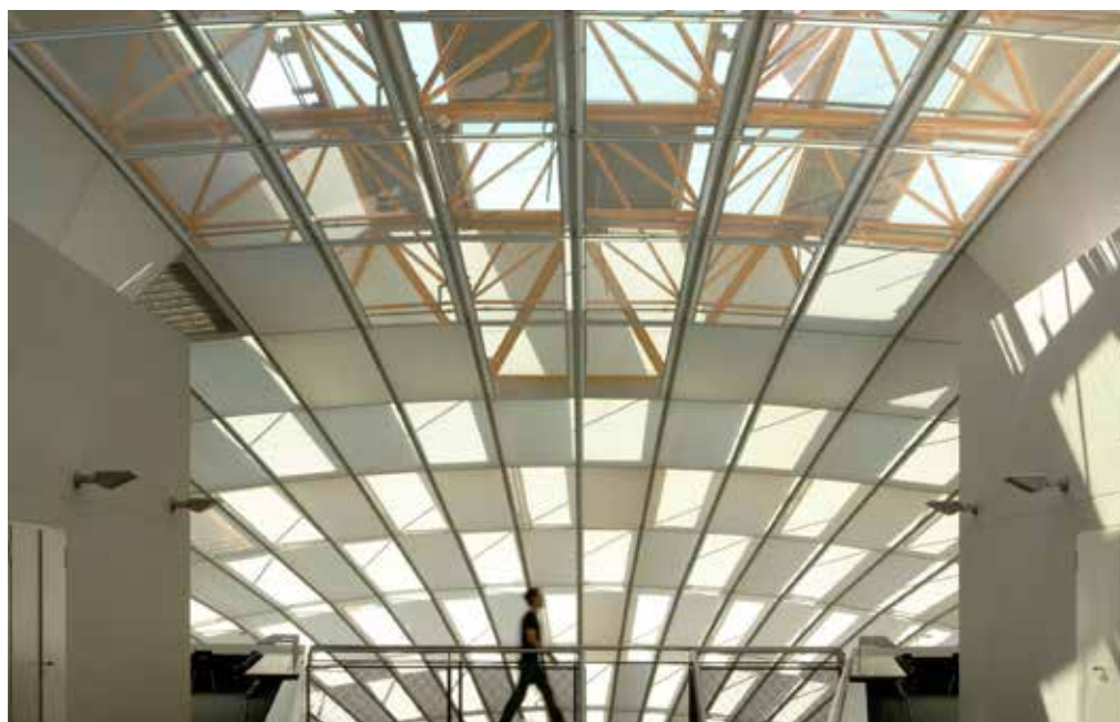
Figura 236 - Fotografia tirada no último piso do edifício, com vista para a cobertura e estrutura. © Nigel Young / Foster + Partners
