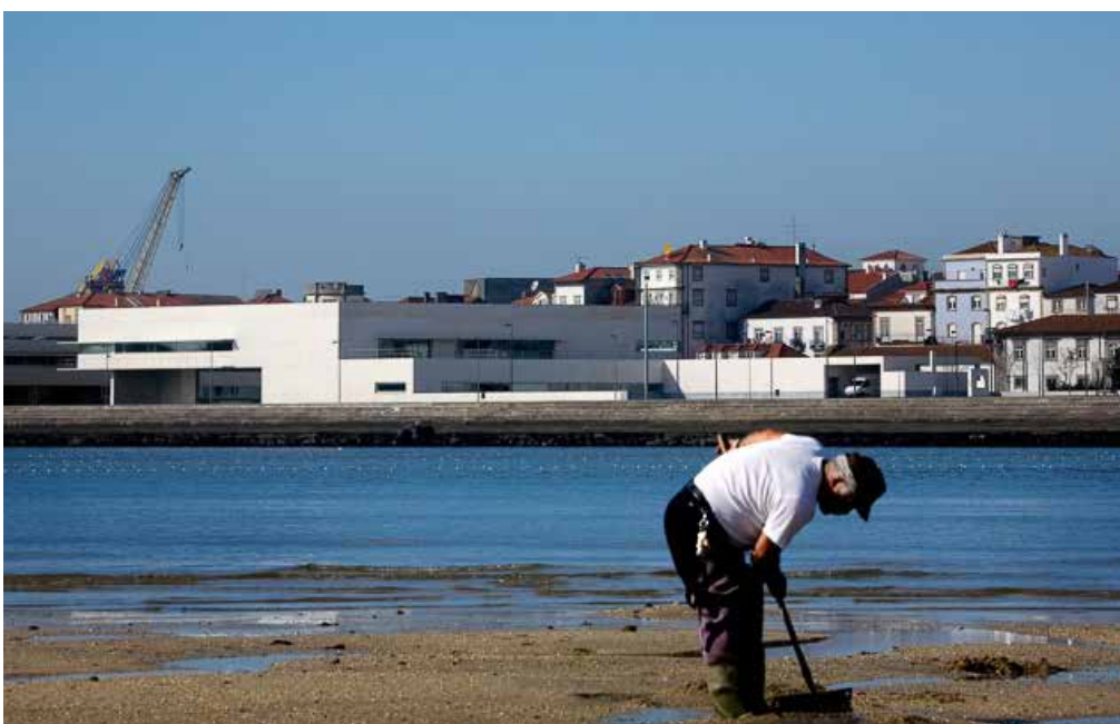
Figura 249 - Vista sobre o edifício através da margem Sul do Rio Lima. © Fernando Guerra
