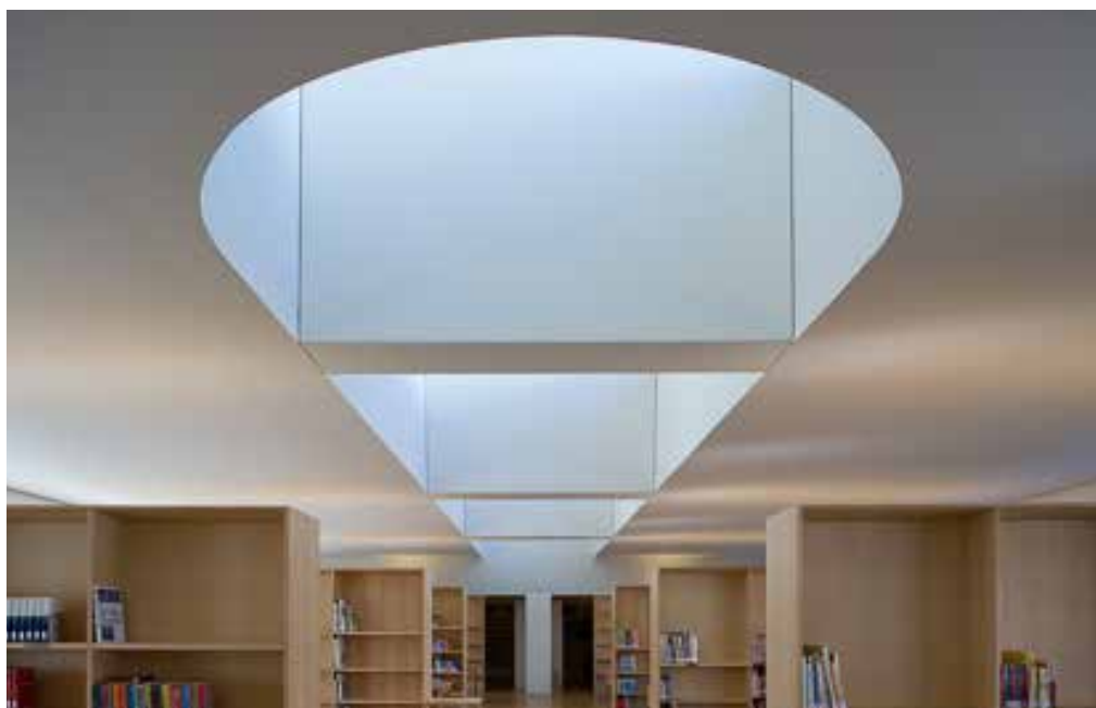
Entradas de luz zenital nas salas de leitura, através dos lanternins.
