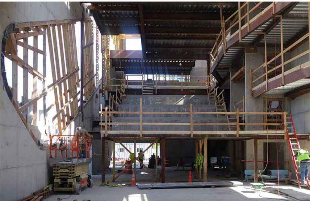
Figura 354 - Fotografia do interior da biblioteca em construção. © Steven Holl Architects
