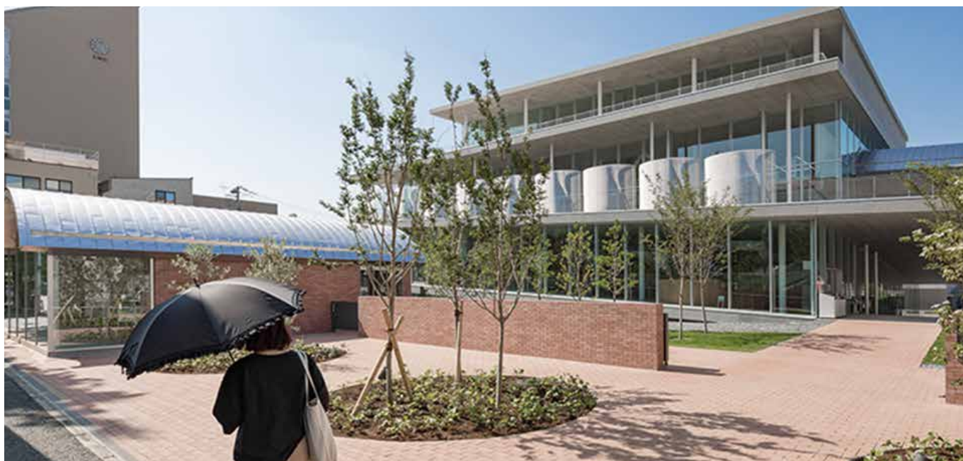
Figura 362 - Vista da fachada principal. © Vincent Hecht
