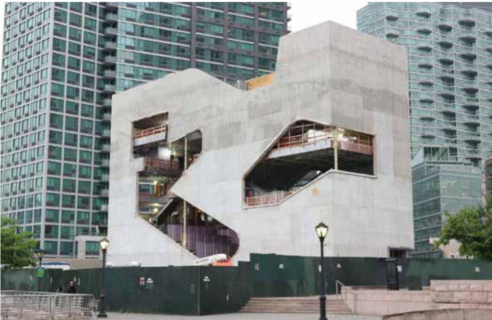
Figura 353 - Fotografia do exterior da biblioteca em construção.
