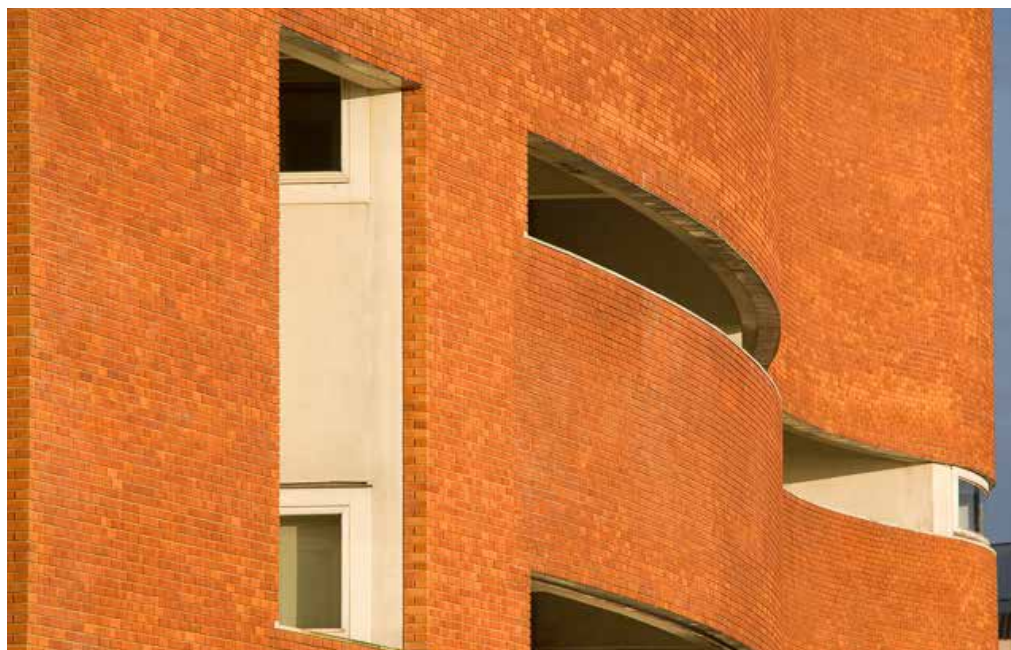
Figura 193 - Vãos na parede curva exterior. © Fernando Guerra
