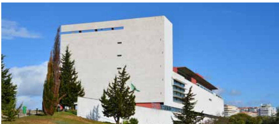
(4) Escola Superior de Comunicação Social Ano de construção: 1990-1994 Arquiteto: João Carrilho da Graça Grupo escolar: Instituto Politécnico de Lisboa Figura 419 - Escola Superior de Comunicação Social.
