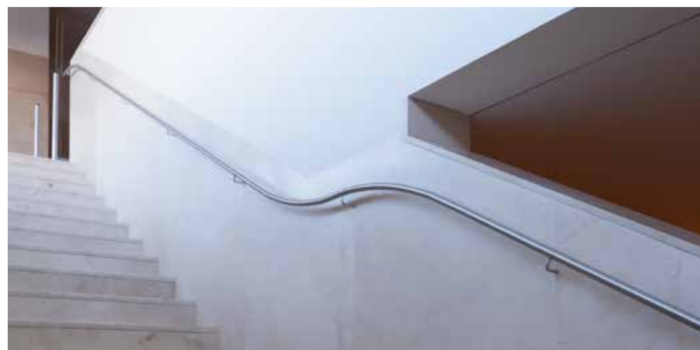
O edifício foi desenhado de modo a ter sempre em atenção a permeabilidade do espaço público. No pilar de Sudoeste, um espelho de água rodeia uma escada de emergência, que permite uma ligação entre primeiro piso e o exterior. O gesto do corrimão foi desenhado com atenção à ergonomia.
