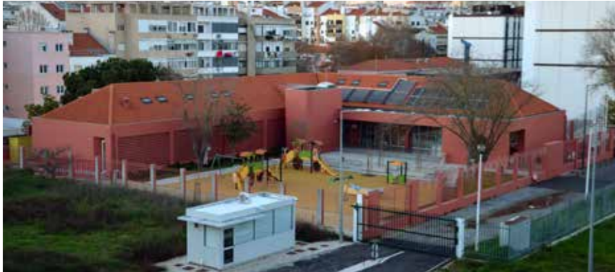
(1) Jardim de Infância n.º 1 de Benfca Ano de construção: 1995 (reabilitação em 2023) Arquiteto: Reabilitação por DSNJ.arq Grupo escolar: Agrupamento de Escolas de Benfca Figura 416 - Jardim de Infância N.º 1 de Benfca.
