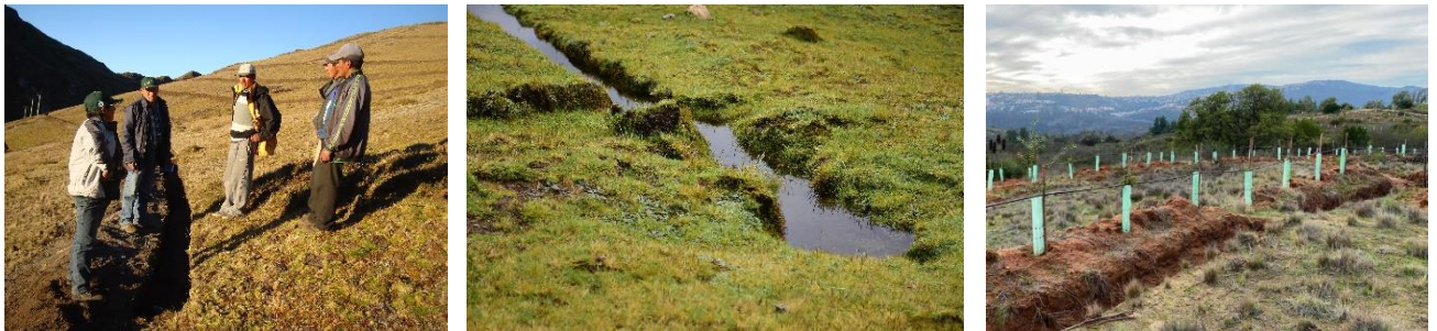
Figura 11 Imagem da esquerda: construção de valas de infiltração na organização comunitária de Auquiraccar, no Perú (imagem de agroruralminagri);
