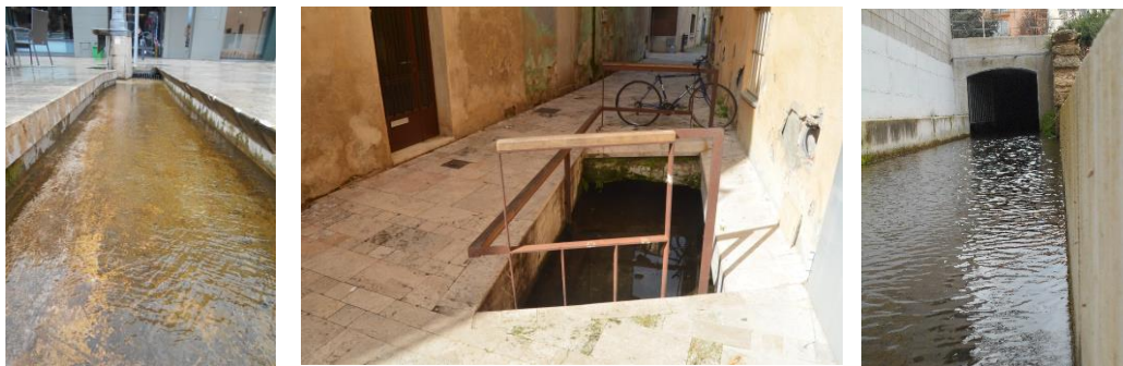
Figura 14 Pormenores do sistema da reabilitação dos sistemas antigos de drenagem, no centro histórico de Banyoles (fotografias do autor, captadas em fevereiro de 2025)
