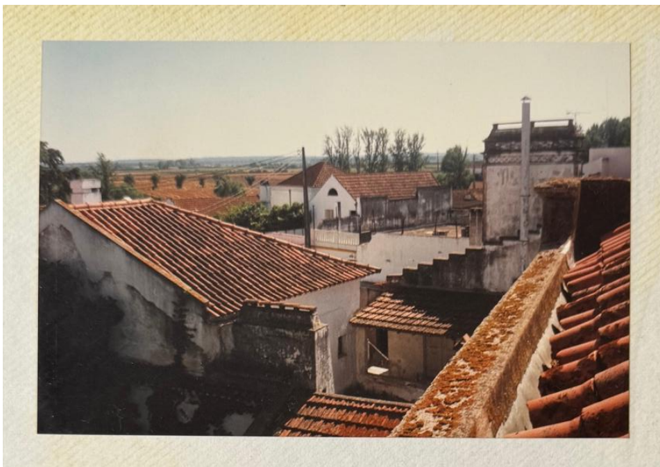
Figura 1 – Vista da casa de Coruche. Arquivo Gonçalo Ribeiro Telles, PT PC,IP/SIPA GRT-02-179
