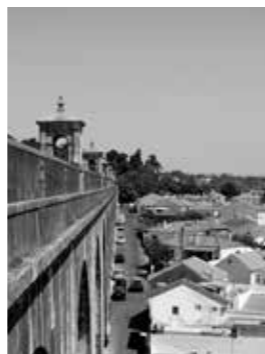
69 Rua dos Arcos, entre as moradias e o Aqueduto - atualidade.
