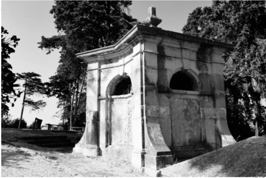
762. Clarabóia do Aqueduto na entrada de Monsanto- atualidade. 763. Chegada do Percurso em Monsanto- atualidade. 764. Ponto de partida no recinto da Meia Laranja - atualidade. 765. Chegada do percurso do Aqueduto a Monsanto. 766. Clarabóia do Aqueduto na entrada de Monsanto - atualidade.
